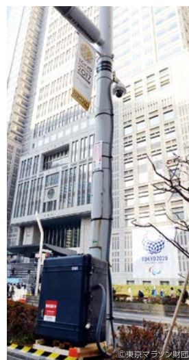
コース上の重要箇所には仮設監視カメラを設置
