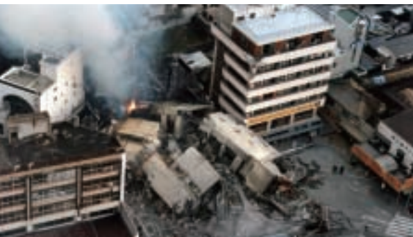
阪神淡路大震災で倒壊したビル
