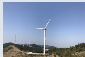
和歌山県にある風力発電所「中紀ウインドファーム」
