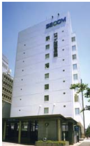
セコム損害保険(株) 本店ビル
