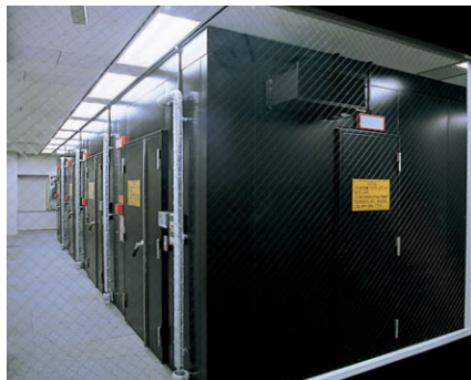
「セキュアデータセンター」シェルタールーム
