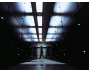
セキュアデータセンター
