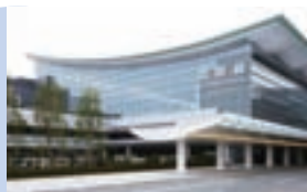
羽田空港新国際線ターミナルビル
