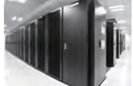
「セキュアデータセンター」
