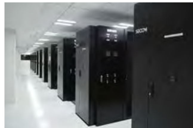
「セキュアデータセンター」
