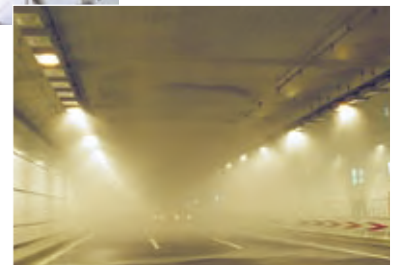
トンネルの水噴霧設備
