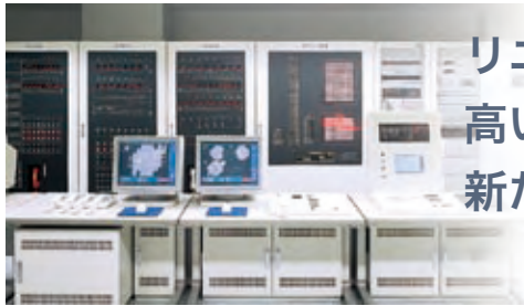
超高層ビルの防災センター
