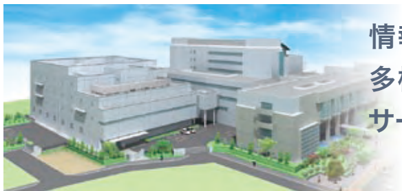
「セキュアデータセンター」新館(左の建物)
