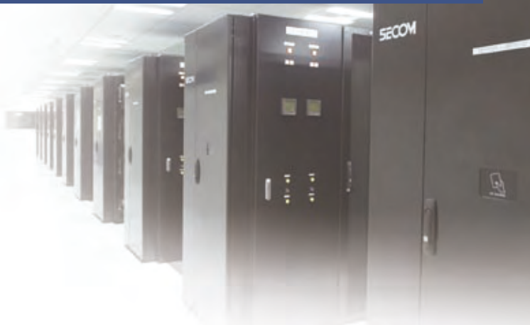
「セキュアデータセンター」のサーバールーム
