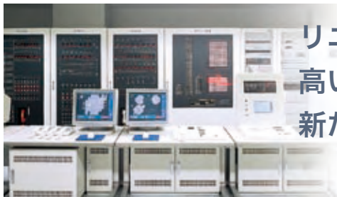
超高層ビルの防災センター
