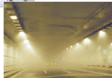
トンネルの水噴霧設備
