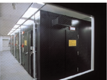
セキュアデータセンター
