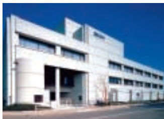
東京中央コントロールセンターが入るセコムSDセンター
