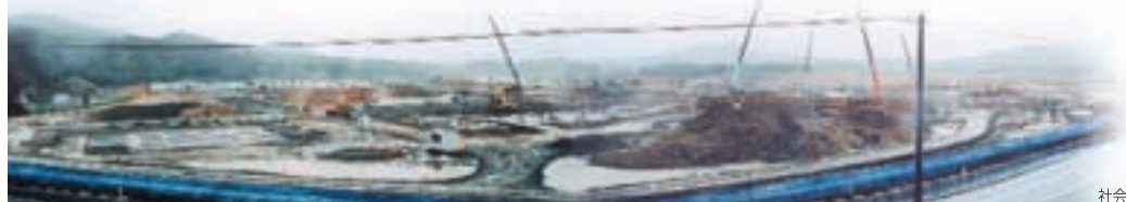
「美祢社会復帰促進センター」建設現場（山口県美祢市）
