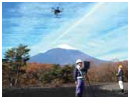
「i-Construction」向けドローンを使った3次元測量
