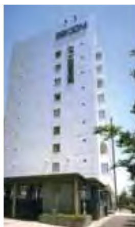
セコム損害保険(株)本店ビル
