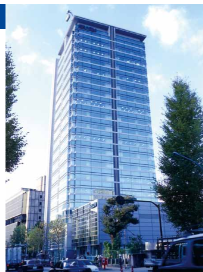
東京原宿にあるセコム本社ビル
