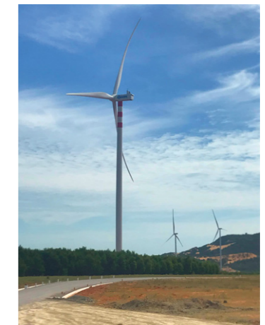
ニッタンの火災報知システムが導入されたベトナム・ニントゥアン省の発電施設
