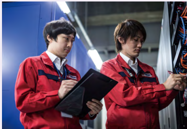
アット東京のデータセンター
