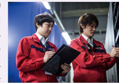
アット東京のデータセンター
