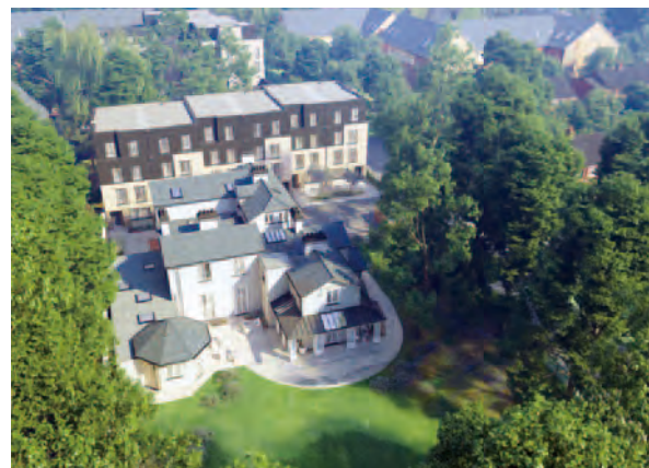
ニッタンの火災報知システムを導入したイギリスにある大学の寄宿舎
