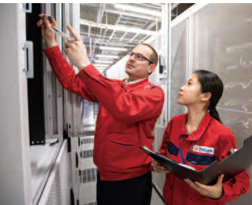
アット東京のデータセンター
