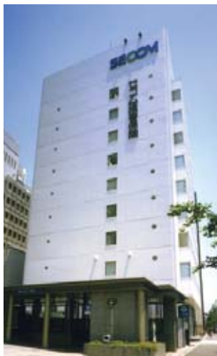
セコム損害保険(株)本店ビル
