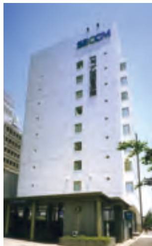
セコム損害保険(株)本店ビル
