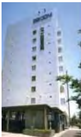
セコム損害保険(株)本店ビル
