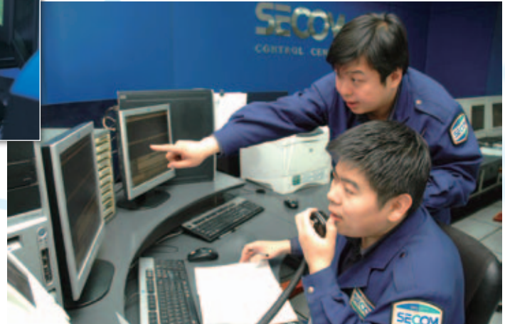
北京京盾セコムエレクトロニックセキュリティのコントロールセンター
