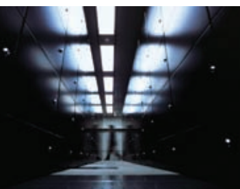
セキュアデータセンター
